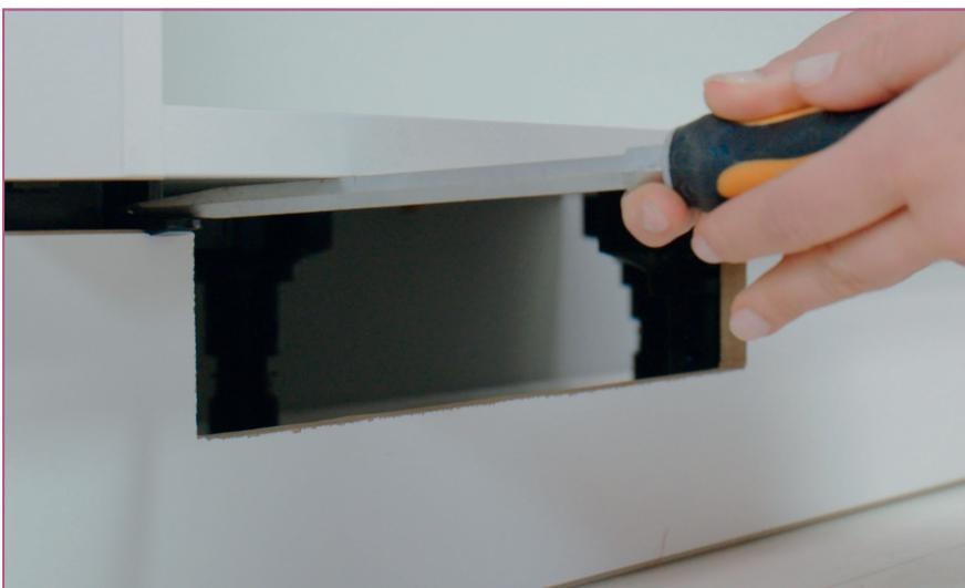
**C >** À l'aide d'un tournevis plat, descendez les fixations contre la plinthe.
